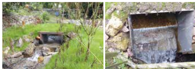
Abb. 13: Einbau einer dritten Sperre im Oberlauf des Zieggraben mit Betonsockel und Blechkasten
