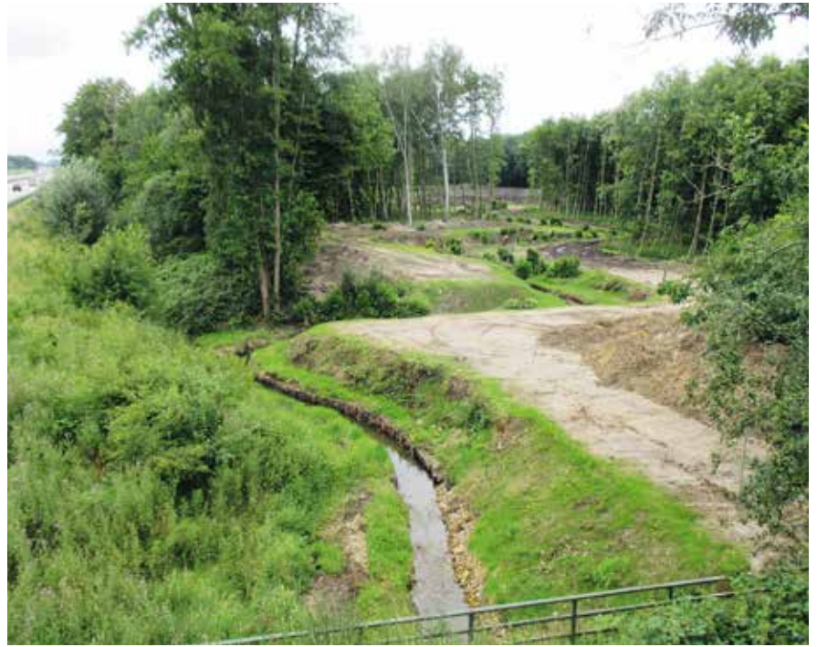
Abb. 4: Rückverlegung des Schierenbaches in den historisch nachgewiesenen Verlauf, Landkreis Vechta
