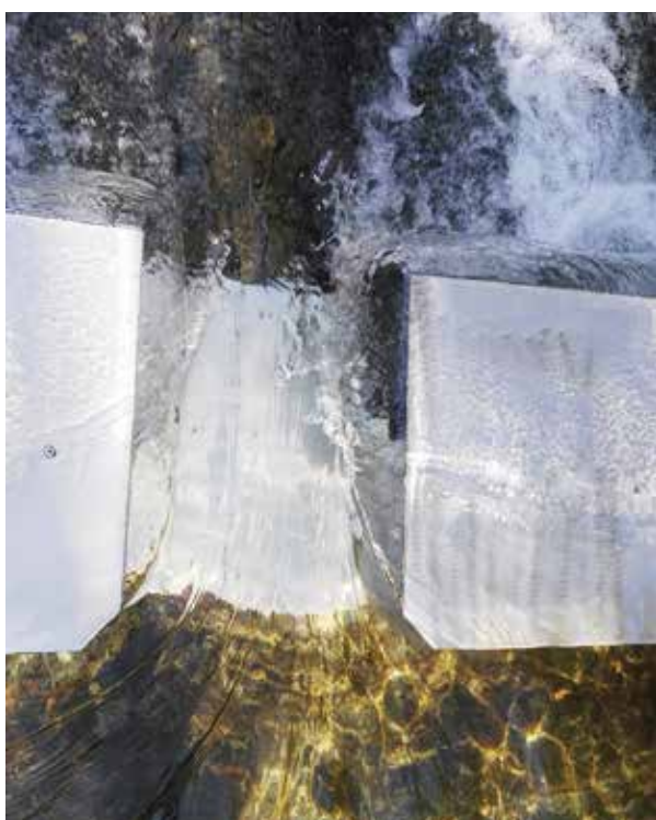
Abb. 2: Der mit Blechen ausgekleidete Schlitz. Man sieht die starke Strömung.
