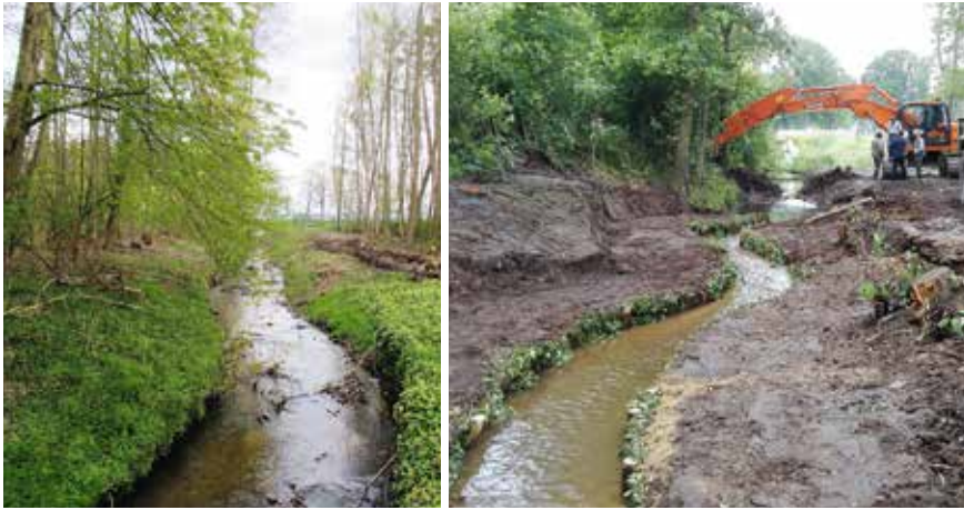
Abb. 2: Einengung des Gewässerprofils durch den Einbau von Faschinen und einem Kies-/Lehmgemisch im Schierenbach, Landkreis Vechta
