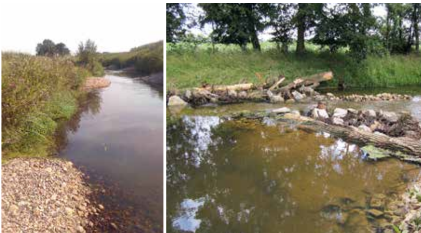
Abb. 3: Einbau von Kies-Strömunglenkern im Calhorer Mühlenbach im Landkreis Cloppenburg (links) und Einbau von Strömunglenkern in der Bever, Landkreis Osnabrück (rechts)
