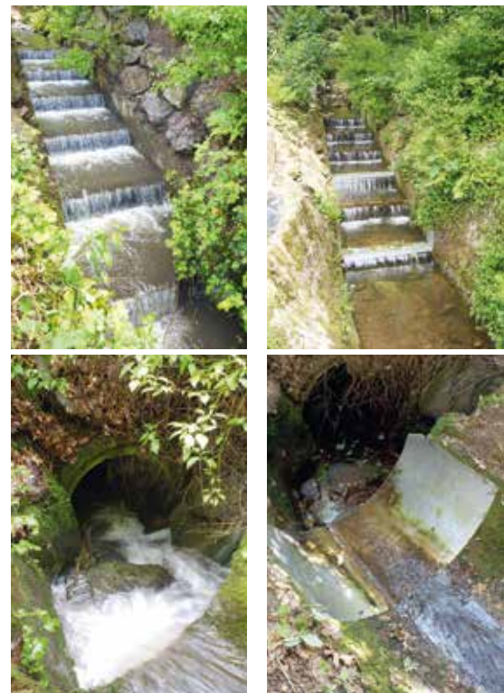
Abb. 10: Zwei hintereinander geschaltete Varianten von Krebschutzblechen im Zieggraben (Abstürze vorher = links und nachher = rechts)
