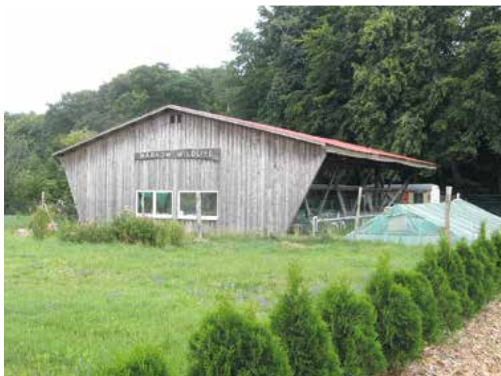
Abb. 6: Ansicht der Kreislaufanlage von außen
