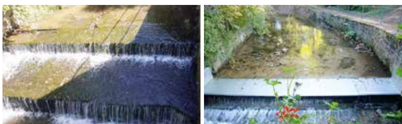
Abb. 5: Maßnahme in der Kander vor und nach Einbau der Krebsperre
