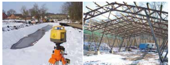
Abb. 4: Neubau- und Sanierungsarbeiten
