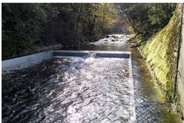
Abb. 1: Krebs Sperre in der Ansicht flussaufwärts. Links und rechts sind Bermen für die Wanderung von terrestrischen Arten zu sehen in der Bildmitte der Riegel mit den auskragenden Blechen.
